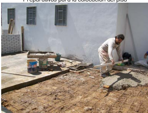
Maniobras para la nivelación del piso
