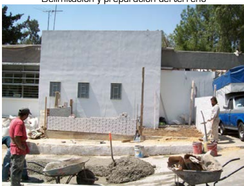
Preparativos para la colocación del piso
