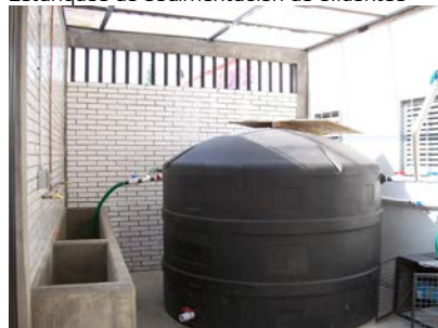
Vista completa del reactor anaerobio R-II
