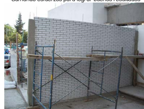
Muro norte listo para la colocación de cadena
