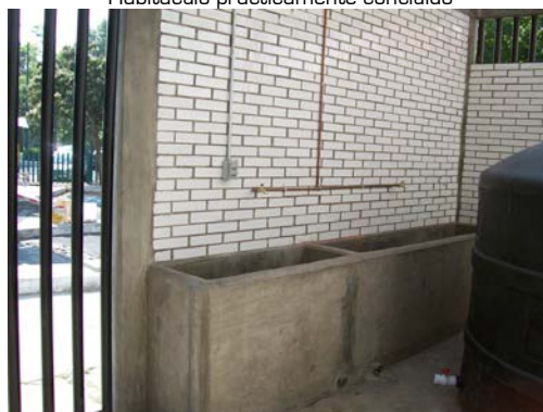
Aspecto final de los estancos de sedimentación
