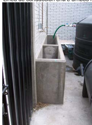
Estanques de sedimentación de efluentes
