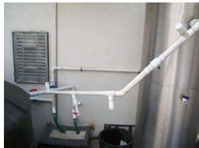
Línea de conducción entre ambos reactores
