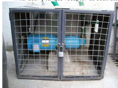
Jaula para el resguardo de la bomba
