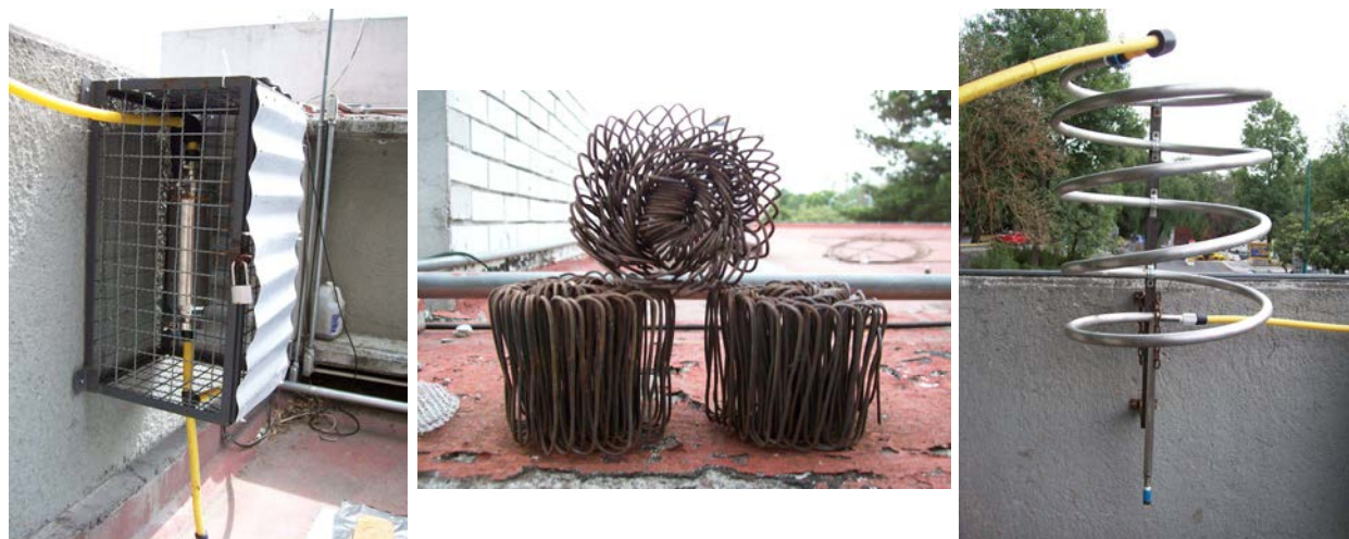
Figura V.8 – Componentes del sistema para el manejo del biogás (I). Izquierda, filtro para la remoción del \text{H}_2\text{S} ; centro, madejas de \text{Fe}_2\text{O}_3 del lecho del filtro; derecha, serpentín
